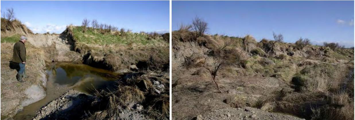
*Illustration 11 - Aperçu des dommages au polder de Ploubalay le 10 Mars 2008 : Vue de la principale brèche (à gauche) et de l'état intérieur de la digue (à droite) (Conservatoire du littoral, 2008).*
