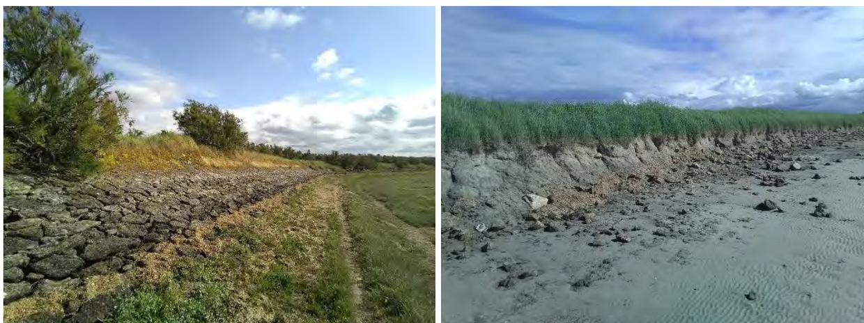
*Illustration 21 – Aperçu de la partie encore empierrée (à gauche) et de la partie érodée (à droite) de la digue des Marais-Neufs le 07 Juin 2020 (BRGM).*
