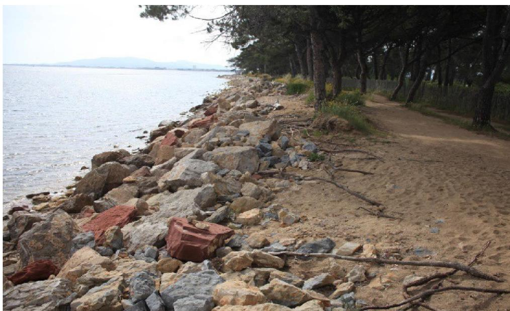
Figure 15: **photographie 3** : enrochement existant sur la plage des Vieux Salins avant les phases de travaux ayant mené à sa disparition. Enquête adapto 2020
