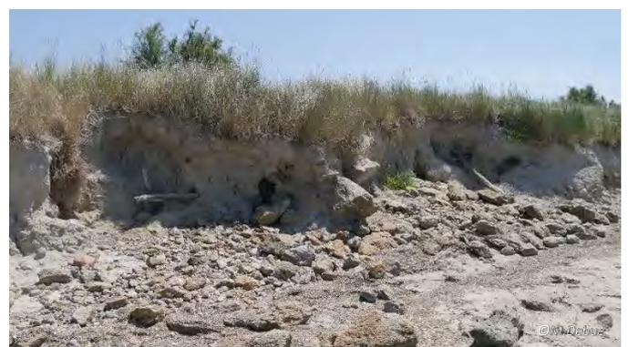
Figure 3 : Illustration de la rive est de la baie de Lancieux et de l'érosion de la digue (2019)
