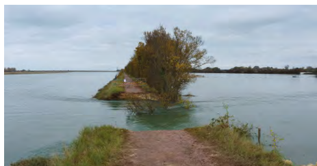
RUPTURE DE LA DIGUE ET INONDATION À MARÉE HAUTE DU MARAIS DE CAGNY EN 2011
