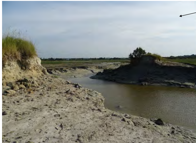
Brèche, vue depuis l'extérieur du polder - Création d'un chenal
