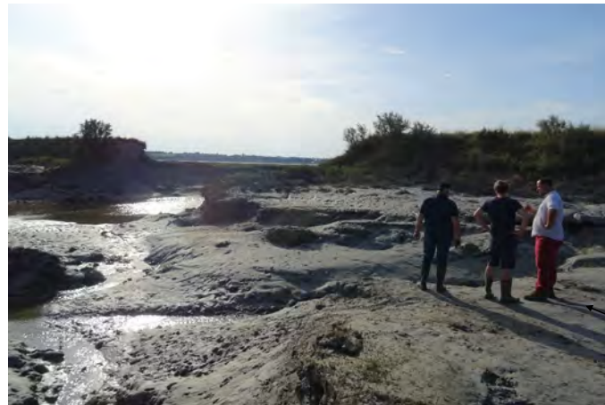
Brèche, vue depuis l'intérieur du polder
