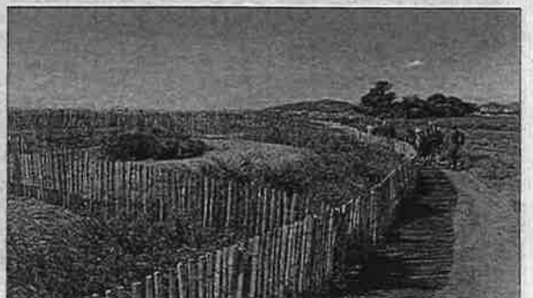
Ci-dessus, au printemps dernier lors du début des travaux de reconstitution du cordon dunaire. Photo de droite : après le rechargement de sable et la pose des ganivelles la nature commence à reprendre ses droits.
